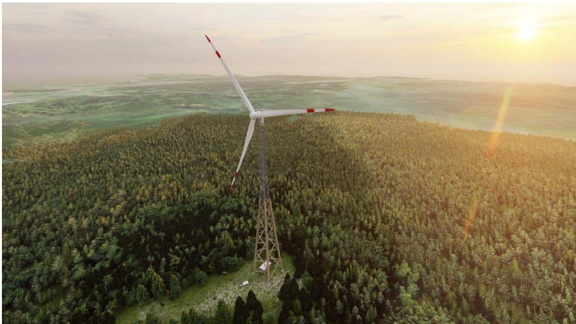
Abbildung 5: Holzturm der Hasslacher Gruppe: Green Wind Tower GmbH
